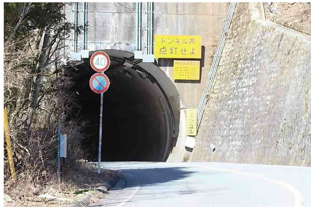
乙女トンネル
